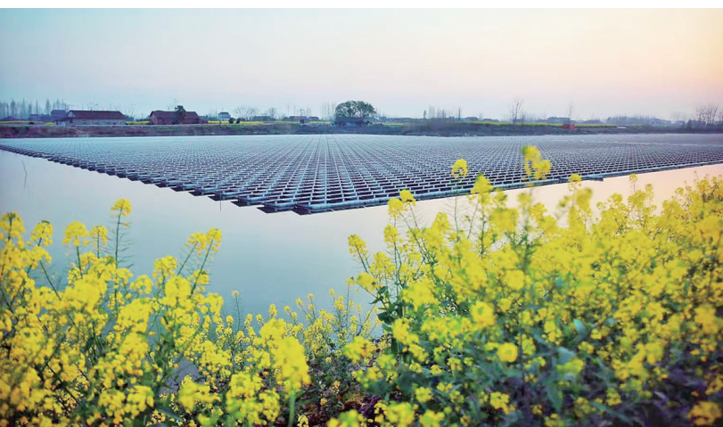
邮储银行湖南省分行支持的北港长河渔光互补100MW光伏发电项目。
