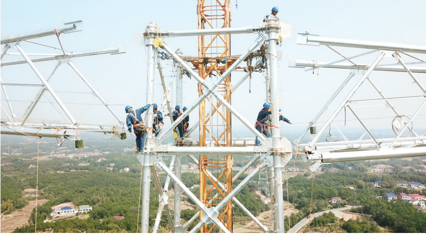
3月13日，长沙县黄兴大道附近，1000千伏南阳—荆门—长沙特高压交流工程线路工程12标段在紧张有序组塔。 石璐 摄
