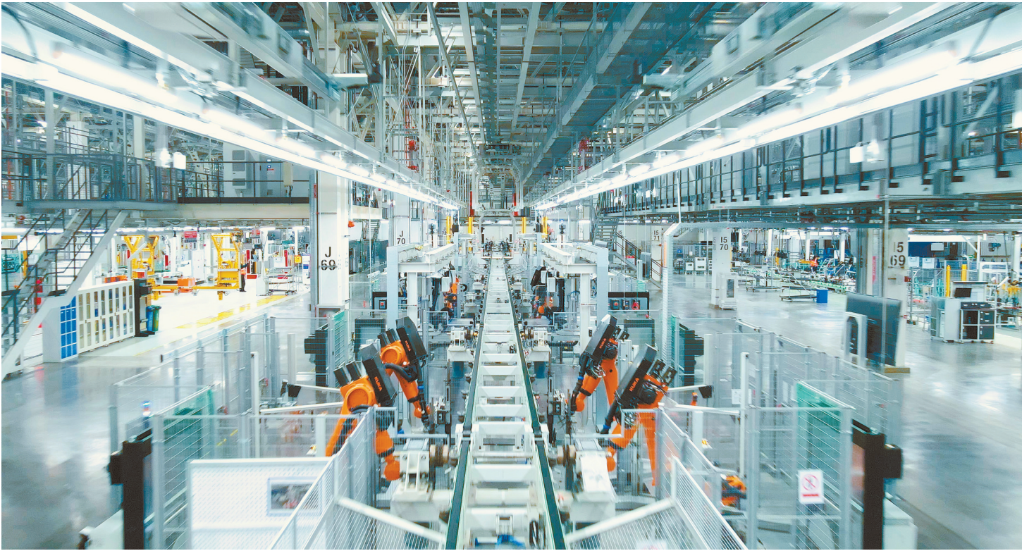
中国是宝马集团的第一大市场。华晨宝马日前公布，在辽宁省沈阳市的投资总额达730亿元人民币。图为华晨宝马沈阳铁西新工厂进行设备安装和调试(2021年12月21日摄)。
