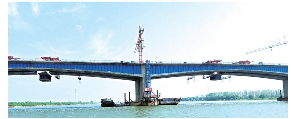
2021年8月20日,平益高速南阳湘江特大桥波形钢板悬吊梁吊装施工圆满收官。
