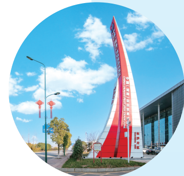
中国（湖南）自由贸易试验区长沙片区。中国（湖南）自由贸易试验区长沙片区管委会供图
