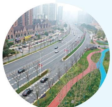
2021年初，完成提质改造的长沙市金星北路旧貌换新颜，这是住建部门落实市委、市政府“四精五有”要求的重要举措之一。 田超 摄
