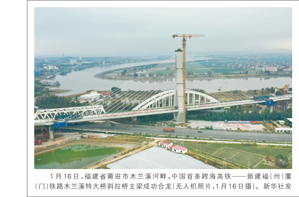
1月16日，福建省莆田市木兰溪河畔，中国首条跨海高铁——新建福（州）厦（门）铁路木兰溪特大桥斜拉桥主梁成功合龙（无人机照片，1月16日摄）。新华社发
