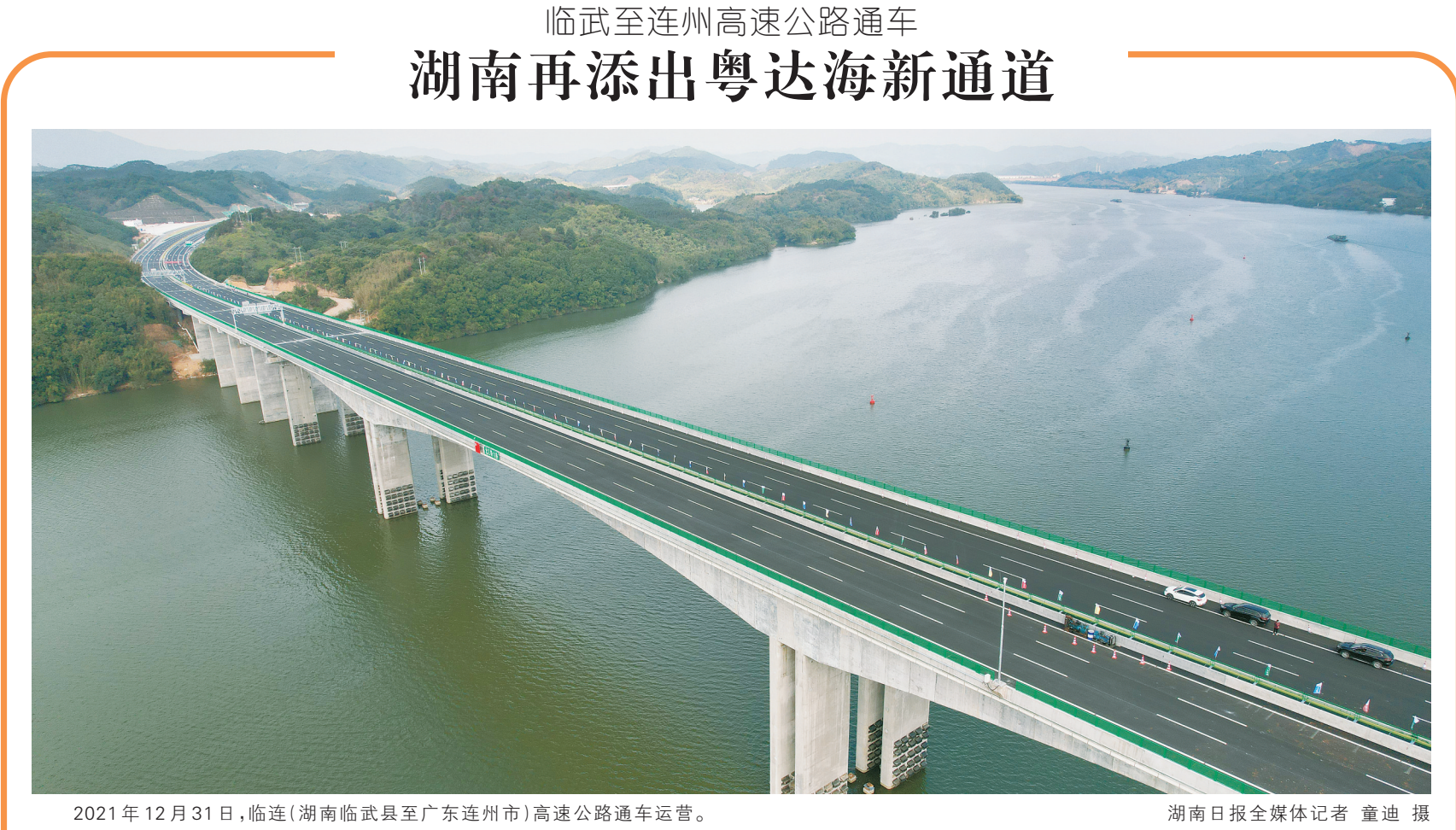
2021年12月31日,临连(湖南临武县至广东连州市)高速公路通车运营。
