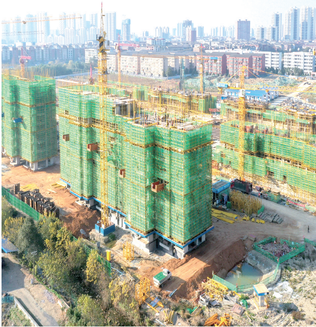
正在建设中的沅江市渔民新村。（本版图片由沅江市委宣传部提供）
