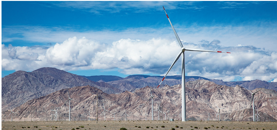
由中车株洲所出品的高海拔风电机组屹立在青海诺木洪风电场。
