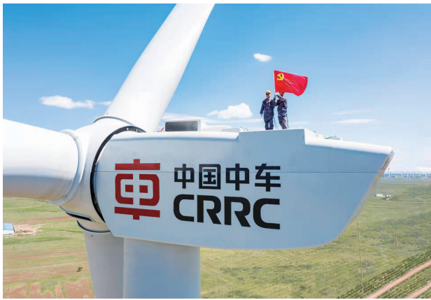
“箕星”平台首推机组5.x MW风力发电机组在张北试验风场成功吊装,刷新当时全球最大风轮直径陆上风力发电机组纪录。
