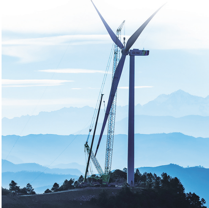
中车株洲所风电事业部的WT3300D146风电机组吊装现场。
