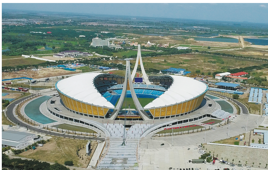
由中国政府援建、中国建筑股份有限公司承建的柬埔寨国家体育场项目18日正式启用。这里将成为2023年东南亚运动会的主要场馆。 新华社发
