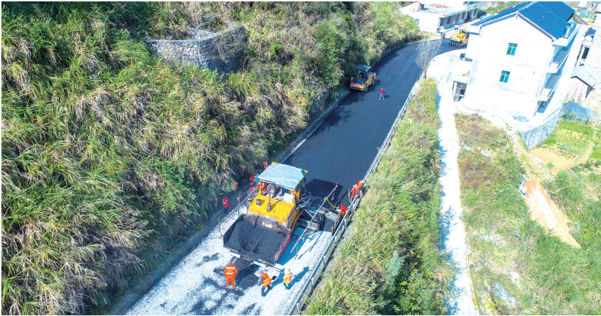
涟源 G207线沥青路面摊铺施工。（娄底市公路建设养护中心供图）
