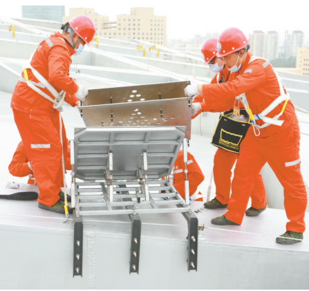
施工人员在北京国家体育场安装浏阳烟花产品。 通讯员 摄
