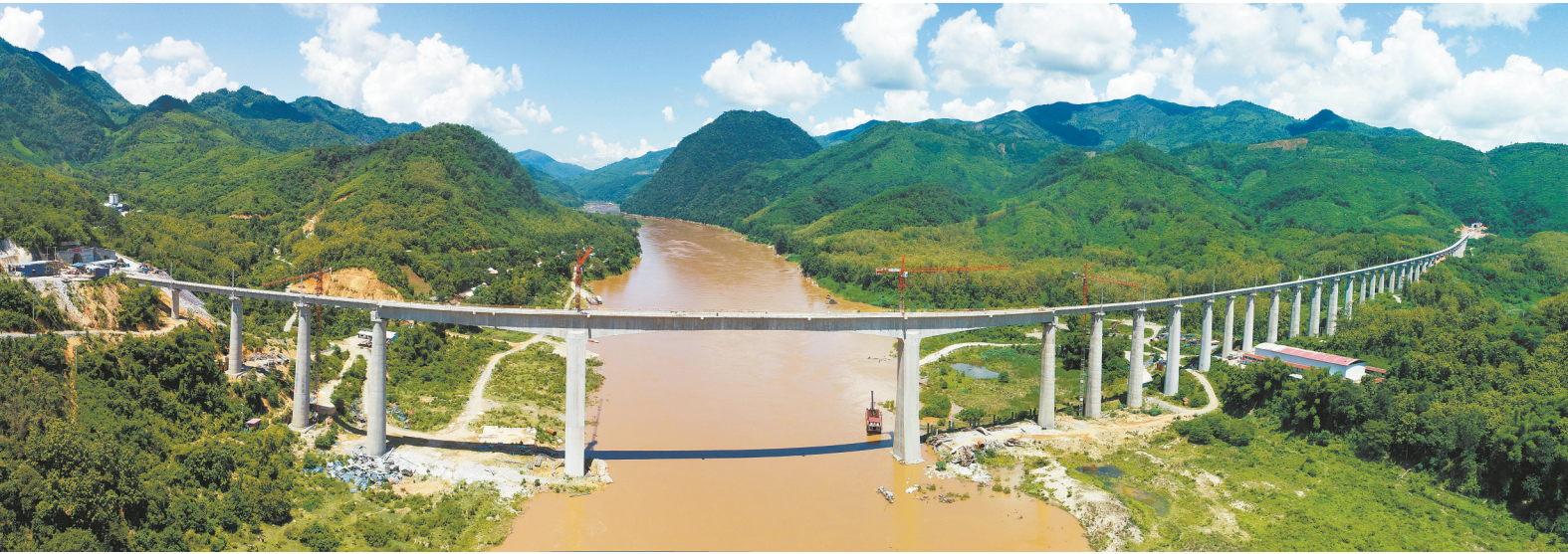
2020年7月24日在老挝拍摄的中老铁路班纳汉湄公河特大桥（无人机照片）。
