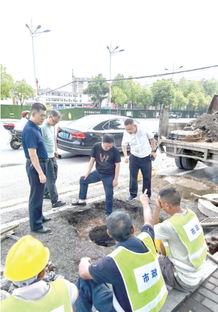
市局领导现场勘察市政道路改造。 (邵阳市城管执法局供图)
