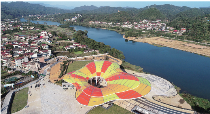
11月11日，鸟瞰浏阳市花炮观礼台，犹如一只巨大彩蝶停留在浏阳河畔。这里是浏阳河“一河两岸”文旅项目的公共活动中心，于4月10日开工改造提质，目前已完成主体工程施工，预计12月可竣工投入使用。 湖南日报全媒体记者 童迪 通讯员 李圣景 摄影报道
