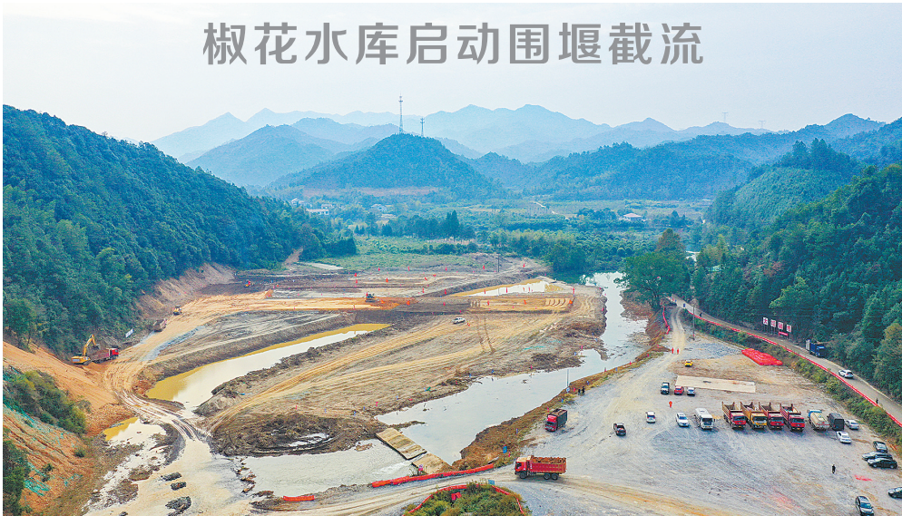
10月31日,浏阳市椒花水库工程围堰截流现场。椒花水库工程总库容为1.6977亿立方米,总投资约60亿元,属于“2021年湖南省重点建设项目”、长沙市2021年“十大基础设施项目”。项目建成后,将有效保障受水区40余万居民的饮水以及长沙经开区、浏阳经开区(高新区)的用水安全。 彭红霞 摄 (相关报道见3版)
