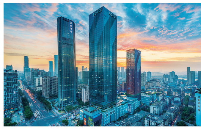
芙蓉中路金融一条街，随着栋栋楼宇拔地而起，现代服务业水平迈上新台阶。
