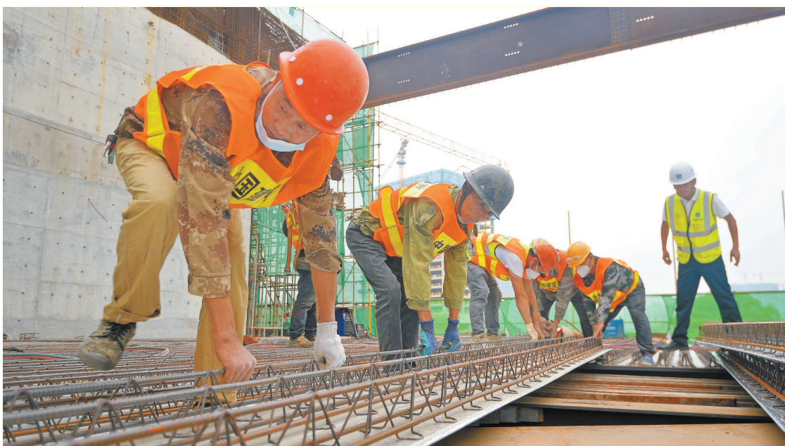
10月6日,长沙市芒果广场(一期)项目建设工地一派忙碌,建设者们坚守岗位,确保工程进展顺利。芒果广场是省重点工程项目,建成后将成为芒果智慧视听产业基地、马栏山开放性文化广场、湖南文旅产新地标。 湖南日报·新湖南客户端记者 李健 通讯员 向丽雅 摄影报道
