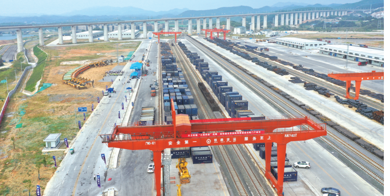
怀化铁路西货场海关监管作业场所工地。
