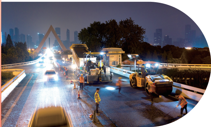
市政部门在不封路的情况下,通过精细化施工,快速修复路面。图为银盆岭大桥路面施工。曹锐 摄
