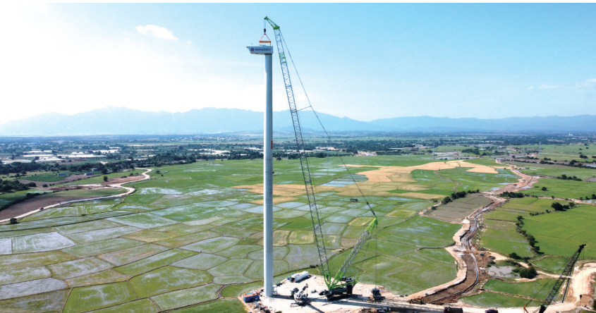
中联重科ZCC9800W履带起重机在越南进行风电吊装作业。
