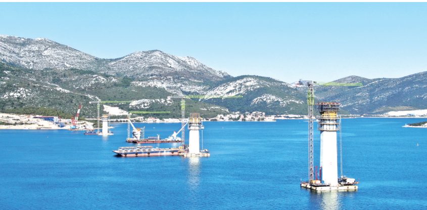
中联重科建筑起重机械助建克罗地亚“统一之桥”。
