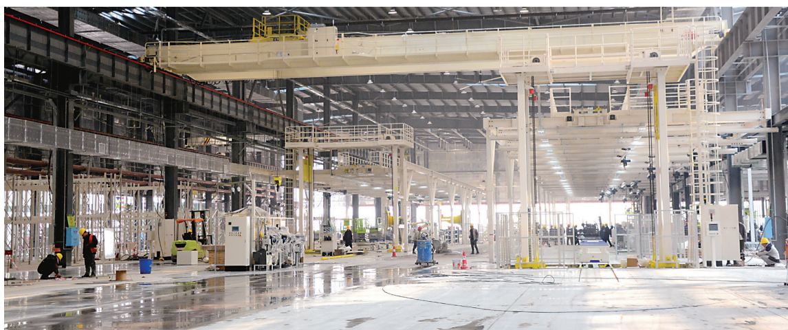
中联智慧产业城建设现场。
