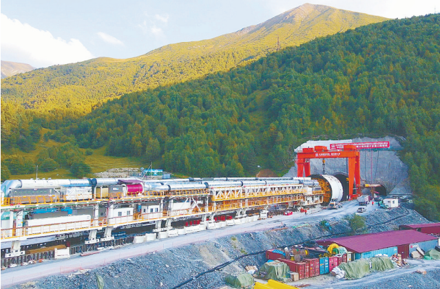
中国制造的全球最大直径全断面硬岩掘进机“高加索号”日前在格鲁吉亚组装完毕并投入使用。该掘进机直径15.08米,全长182米。
