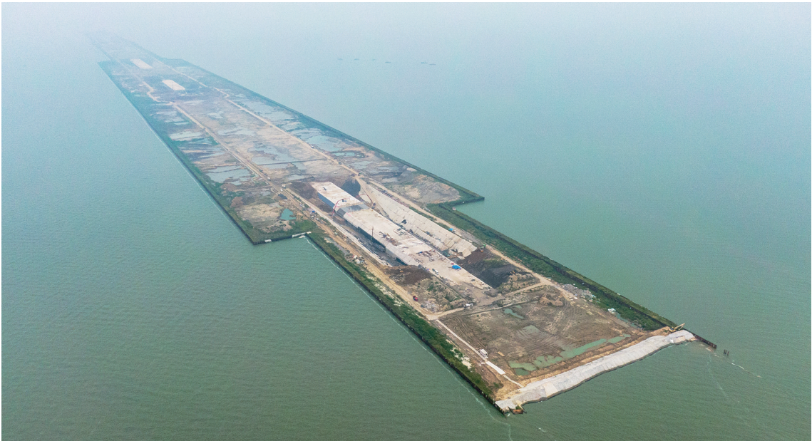
9月5日，国内在建最长湖底隧道——苏锡常南部高速公路太湖隧道（长10.79公里）南泉段最后一节顶板顺利浇筑完成，标志着太湖隧道南泉段主体工程施工全部完成。
