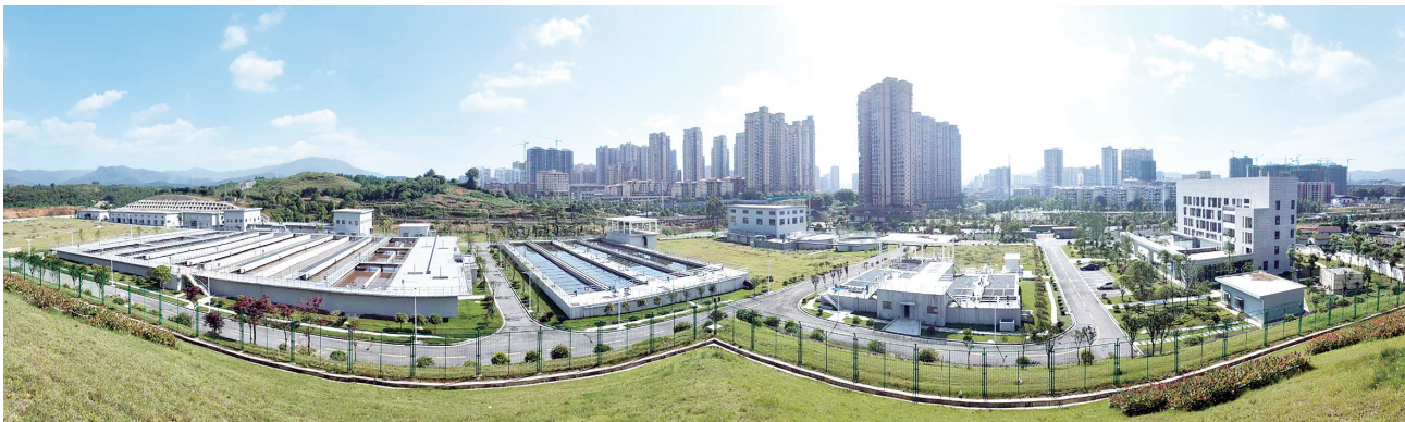
怀化市城东污水处理厂,每天为太平溪下游生态补水3.5万吨,出水水质达到国家城镇污水排放一级A标准。
