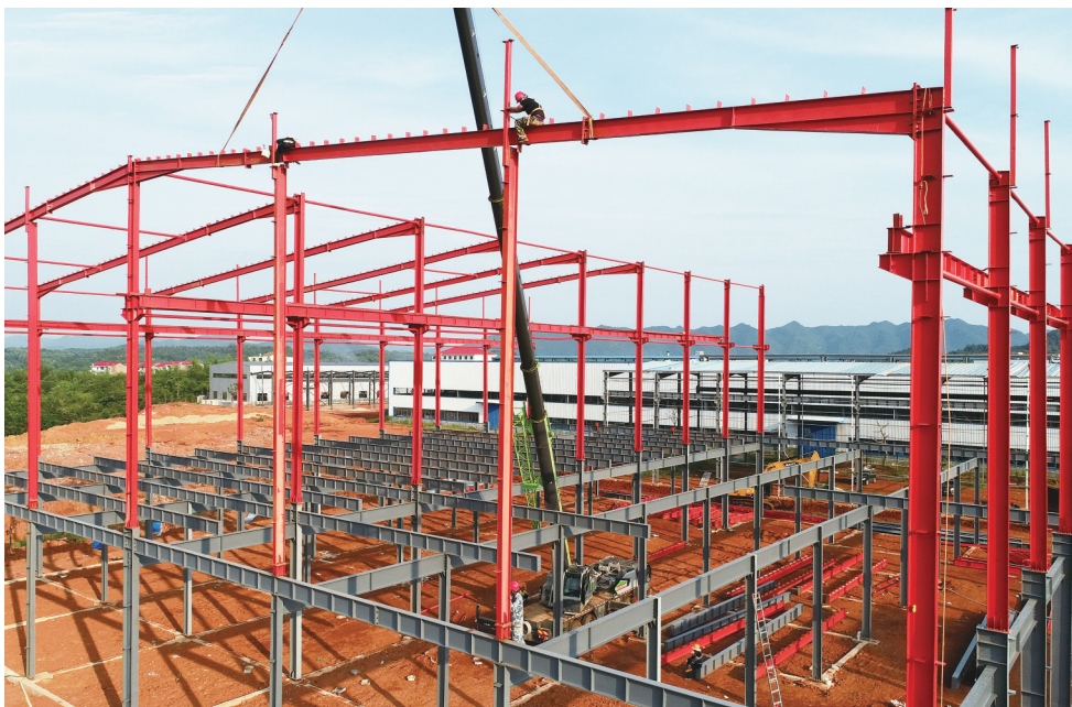
8月20日,双峰县湘东机械制造有限公司扩建项目工地,工人在20米高空抓紧搭建标准厂房。近年来,该县优化产业园区营商环境,鼓励企业新建、扩建标准厂房。目前,全县32家企业建设标准厂房22万平方米,助推“五好”园区建设。
