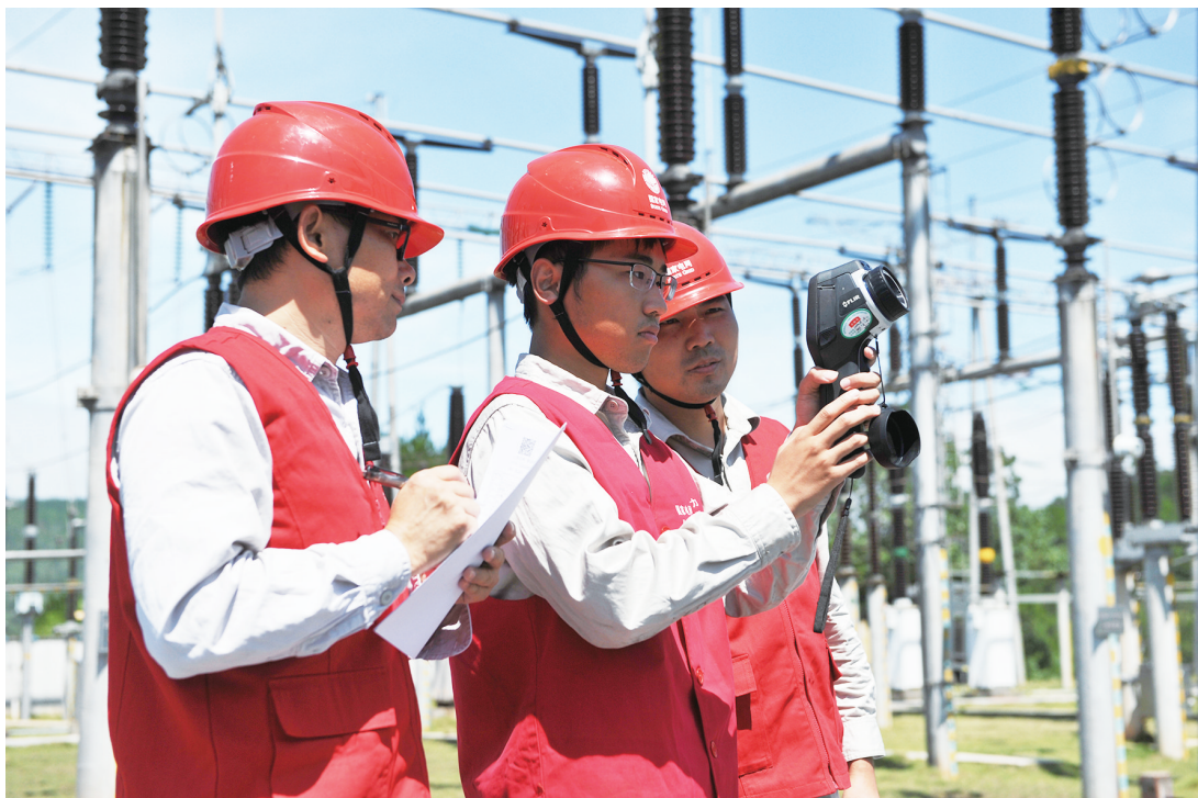
国网郴州供电公司工作人员开展供电设备巡视消缺工作。
