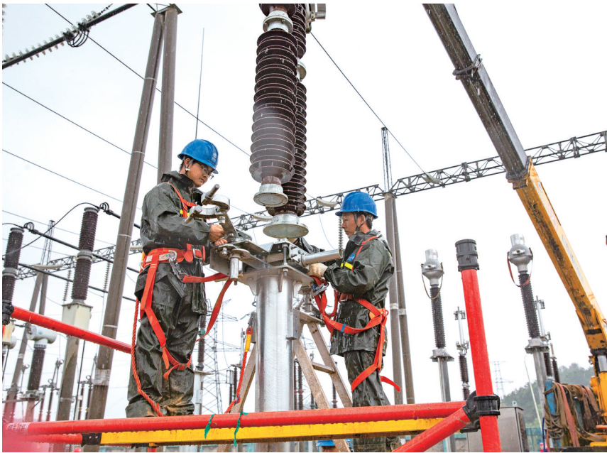
国网娄底供电公司工作人员正加快推进变电站建设。
