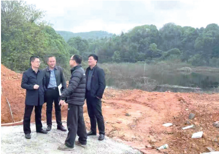
长沙市委巡察组推动解决群众反映的出水涵洞被堵、排水不畅问题。
