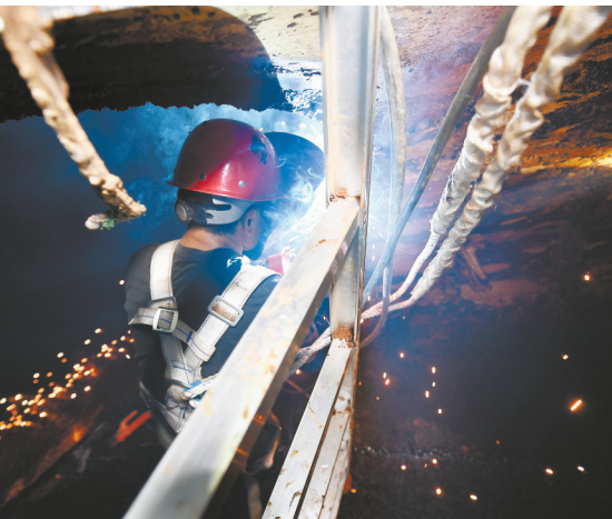
上图：7月13日凌晨，无损检测工程师在对抢修完后的水管线进行焊缝检测。 下图：7月13日凌晨，抢修工人在水管线内进行焊接。 均为湖南日报·新湖南客户端记者 傅聪 摄
