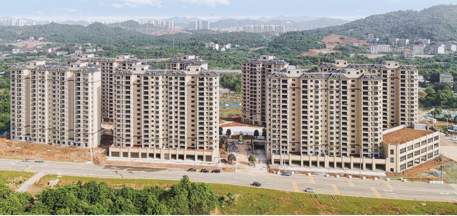
涟钢周边环境综合治理安置区一期。（本版图片由娄星工业集中区提供）
