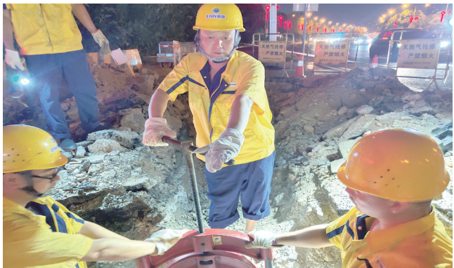
2020年9月28日,捞刀河大桥南天然气管抢修现场。
