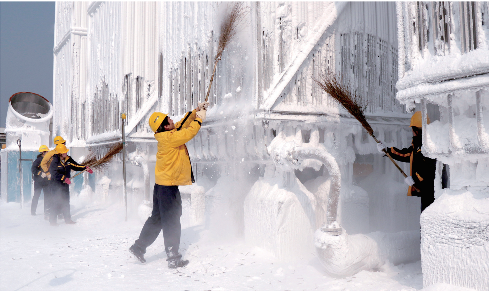
寒冬开展除冰行动,保护燃气设施设备。(本版照片除署名外均由长沙新奥燃气有限公司提供)
