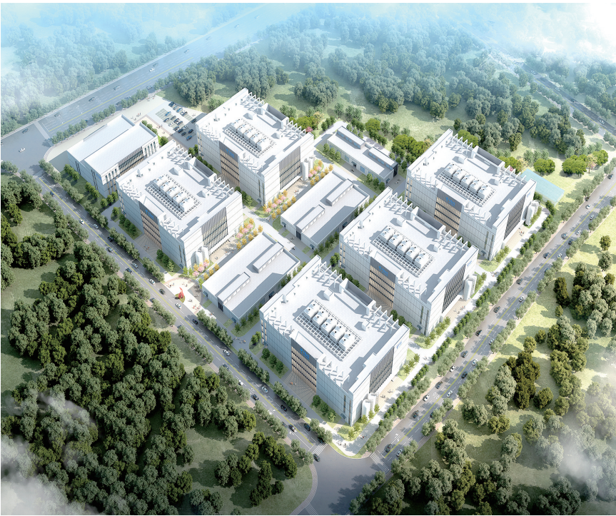
中国电信天翼云中南数字产业园项目效果图，该项目为迄今湖南省内投资最大的数字新基建标志性项目。（本版图片由天心区融媒体中心提供）
