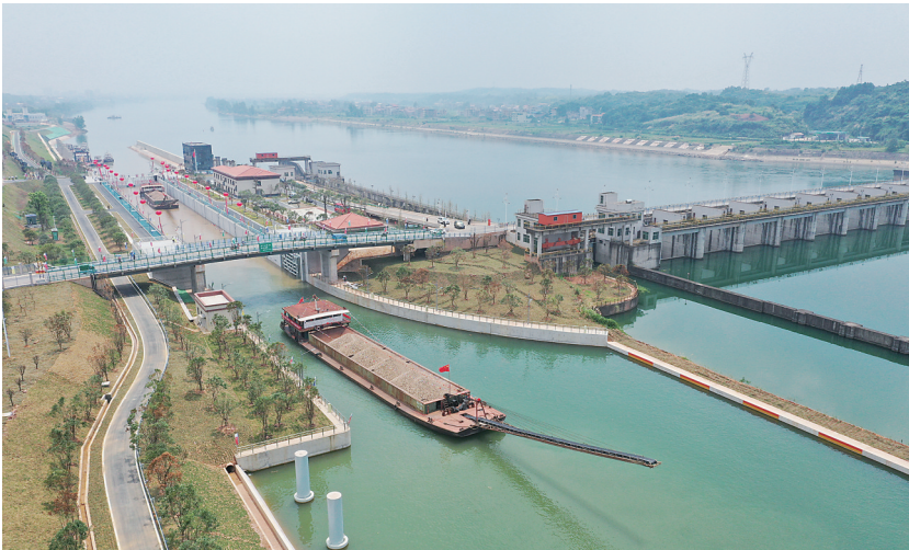
2021年6月24日，湘江湘祁枢纽二线千吨级船闸正式通航。
