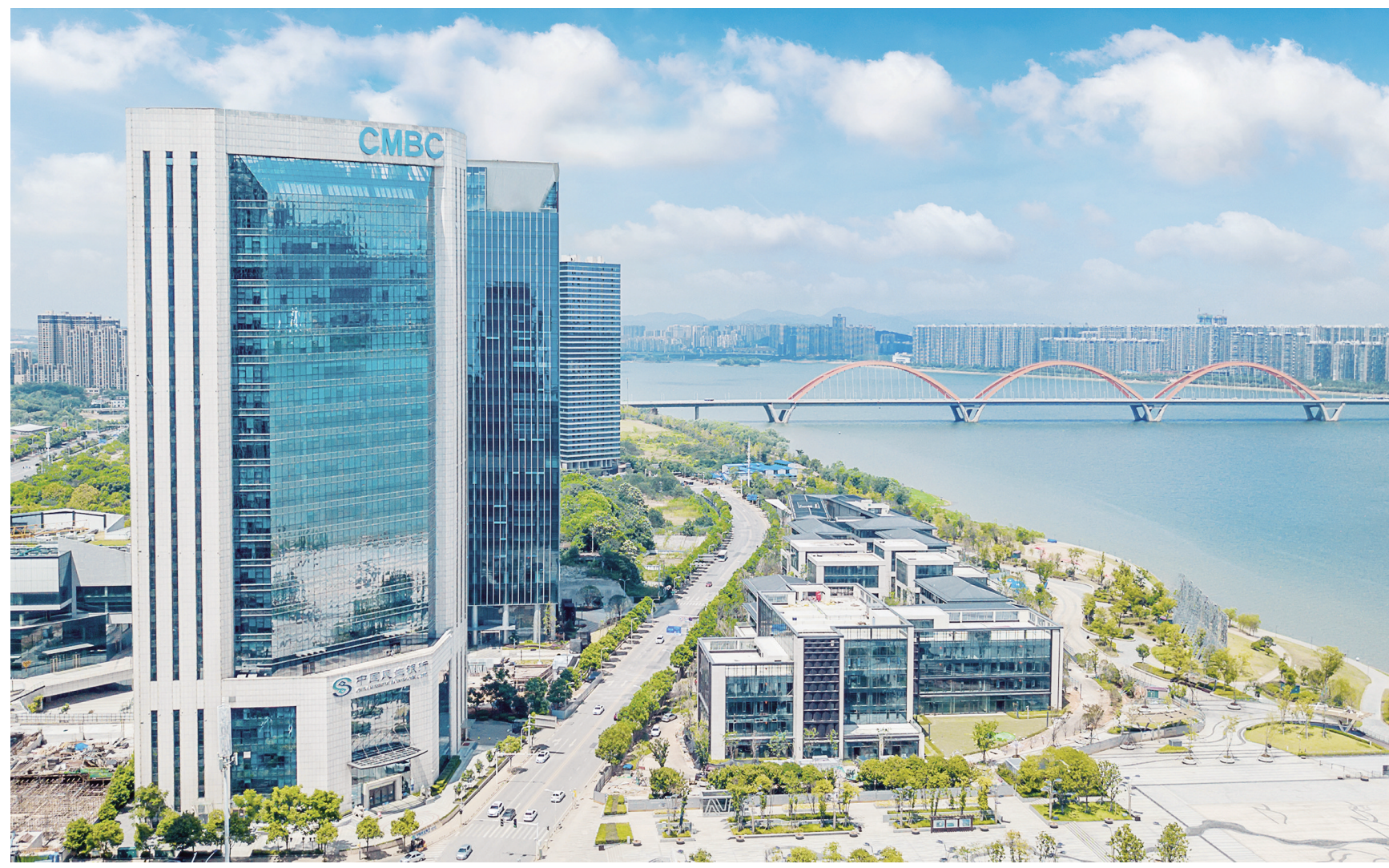
中国民生银行长沙分行大楼。(本版图片由中国民生银行长沙分行提供)
