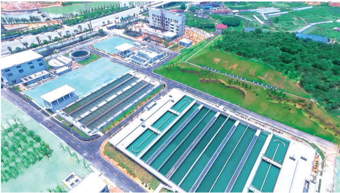
怀化市水务下辖的城东污水处理厂。
