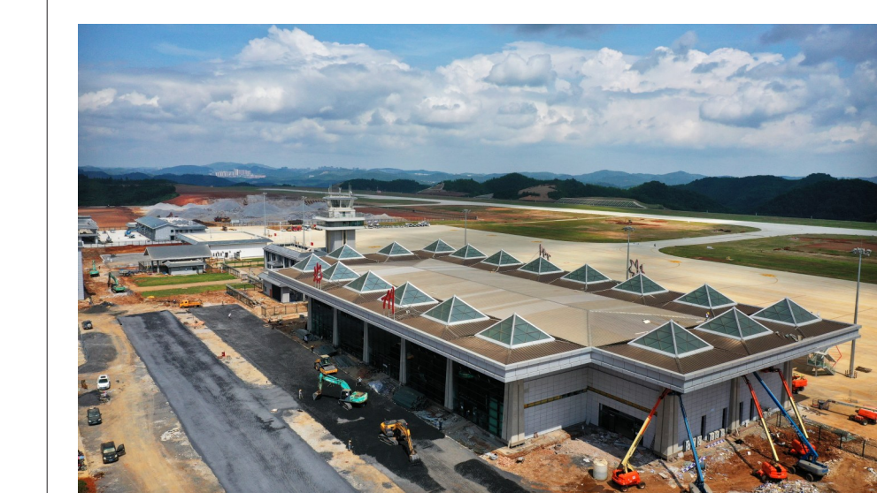
郴州北湖机场建设正酣
