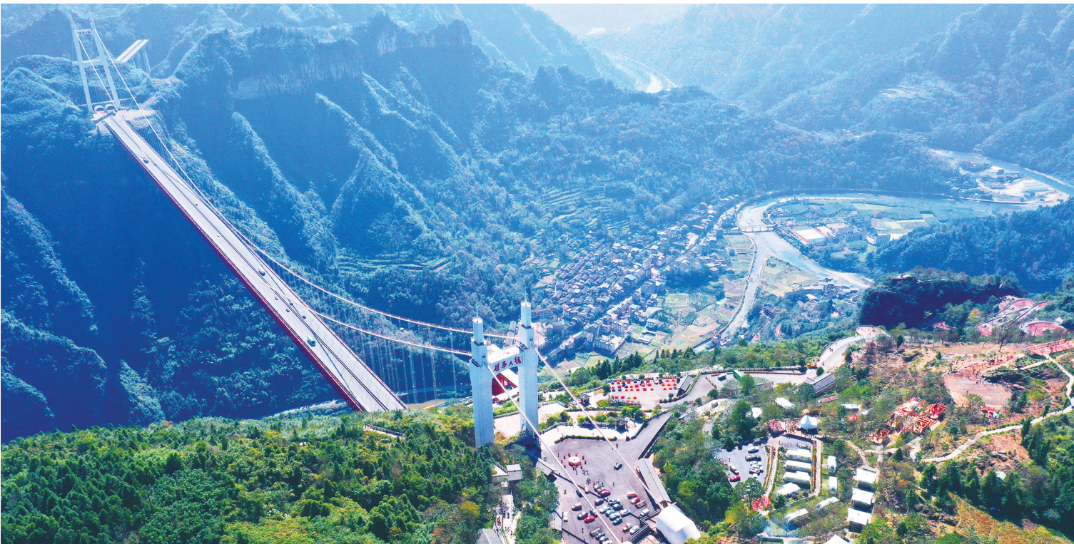
俯瞰吉首市矮寨大桥及茶峒岸天桥仙居。
