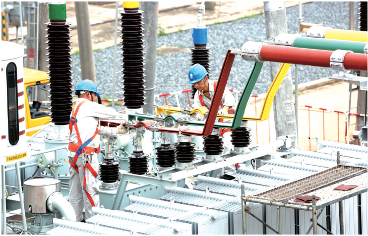
国网岳阳供电公司抢抓工期，大力推进电网建设项目。（国网岳阳供电公司供图）
