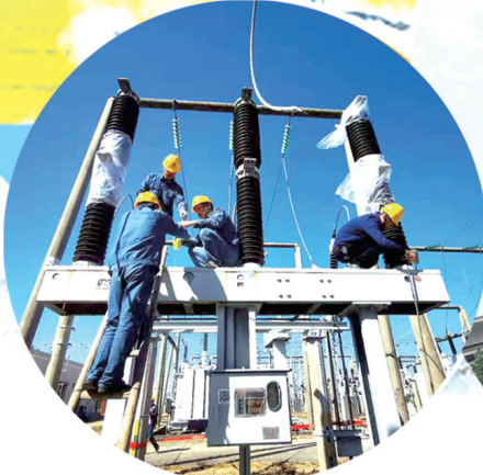
汝城分公司工作人员正在进行变电站设备检修。 赖雪婷 摄
