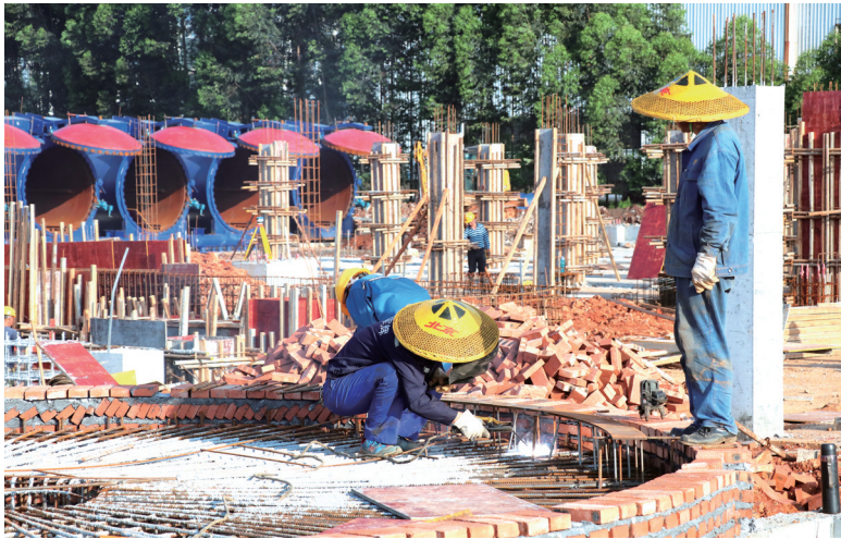
4月29日，位于苏仙区的环保科技型华润能源产业链项目现场，工人们正忙碌地施工作业。何庆辉 摄
