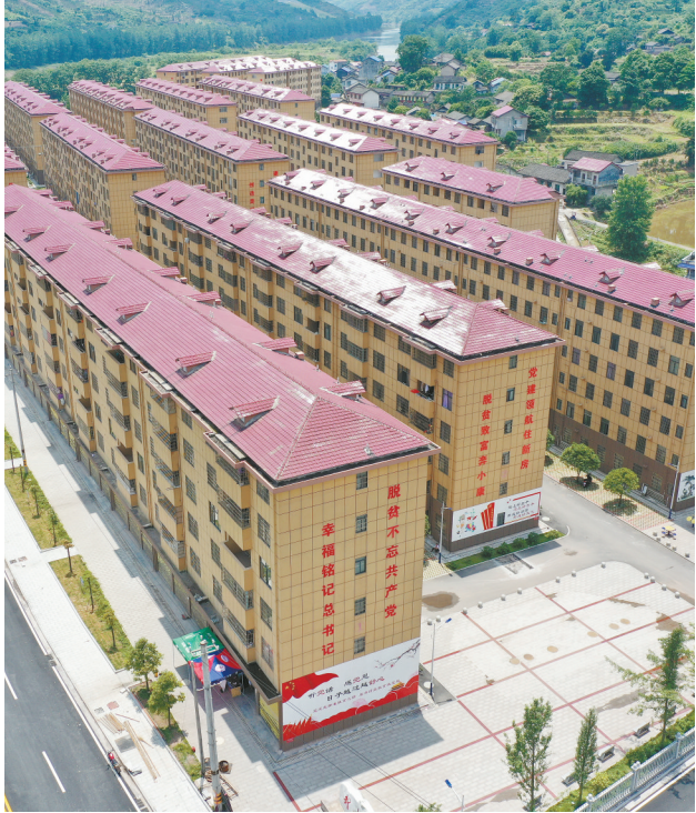
泸溪县武溪镇易地扶贫搬迁安置小区——武水花园。 通讯员 摄
