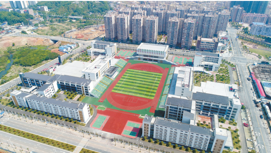
平江县易地扶贫搬迁洪家墩集中安置区配套工程——桂花学校。 通讯员 摄
