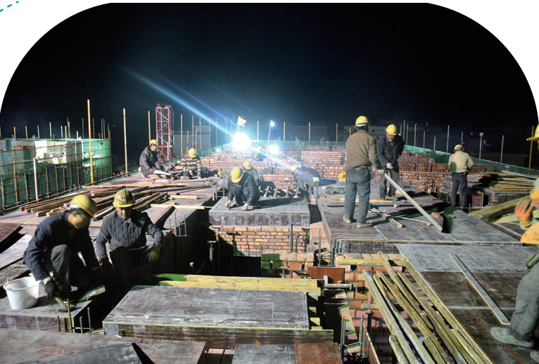
湖南建工集团的建设者日夜奋战在易地扶贫搬迁工程项目建设现场。
