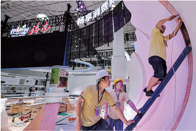
4月27日，工人在位于海口的海南国际会展中心为消博会搭建布展。新华社发
