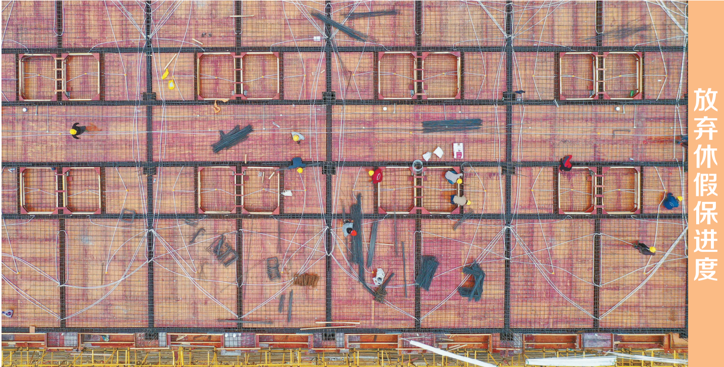
4月5日,道县陈树湘党性教育基地项目工地,建设者在紧张施工。当日是清明小长假第三天,工地建设者放弃休息,抢晴天、抓质量、保进度,确保项目如期完工。
