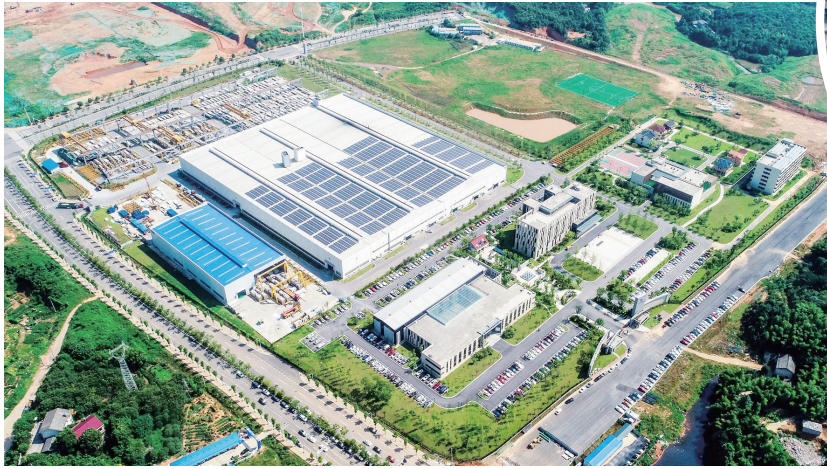
筑友集团长沙科技产业园 (筑友智造科技提供)
