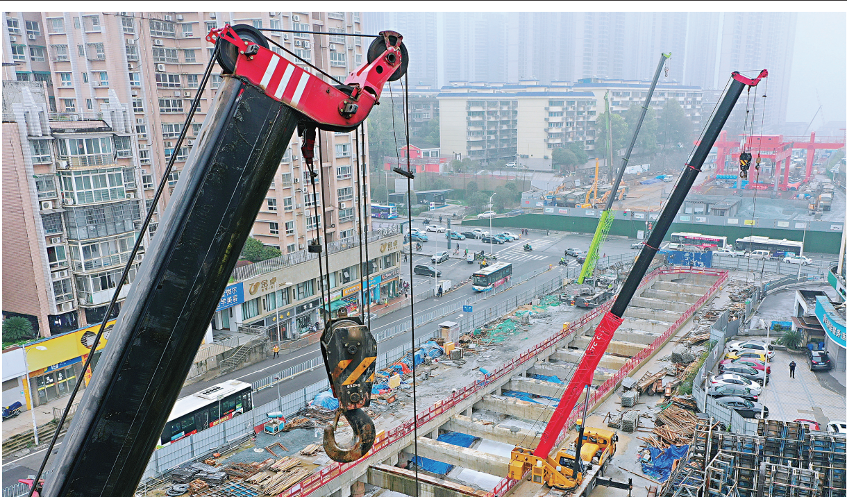
3月16日，长沙市岳麓区桐梓坡路银盆南路路口，随着长沙地铁6号线六沟垅站西区05段顶板完成浇筑，该站主体结构顺利封顶，这也标志着该线路河西段14座车站全部实现封顶，正式进入车站装修阶段。
