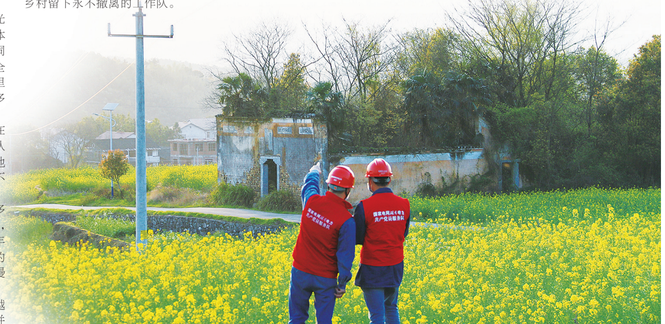
国网湖南电力员工在双牌县澧泊镇沙背甸村巡视10千伏石坪线。 申舒涵 摄 (本版图片除署名外均由国网湖南省电力有限公司提供)
