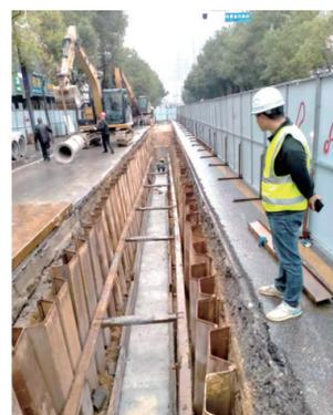
浏阳城区百宜河雨污分流路基及基础开挖施工。
